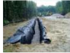
Fossés remplis de substrats
