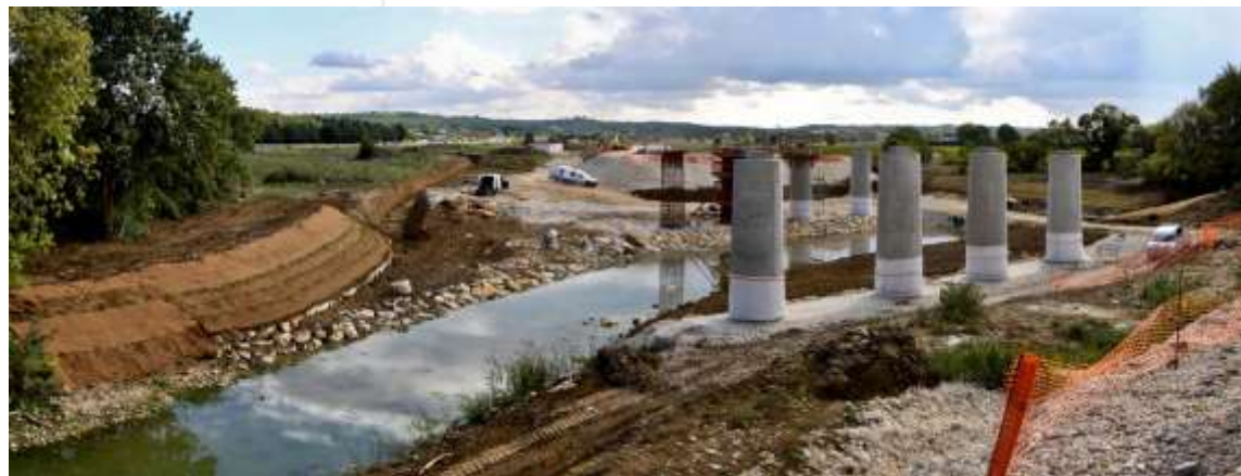
Confortement des berges de la Braune dans le cadre de l'extension de la RN 106
